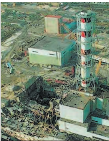
Зруйнований 4-й енергоблок Чорнобильської АЕС. 1986 р.
